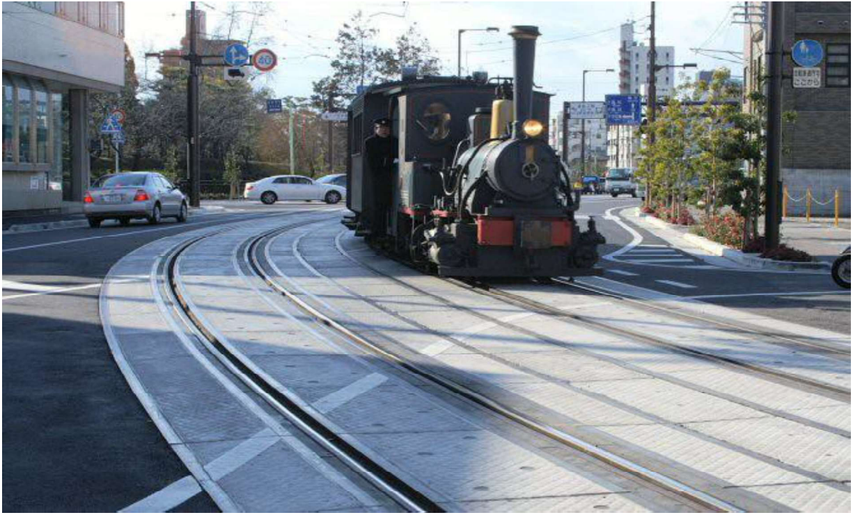
併用軌道 曲線部
