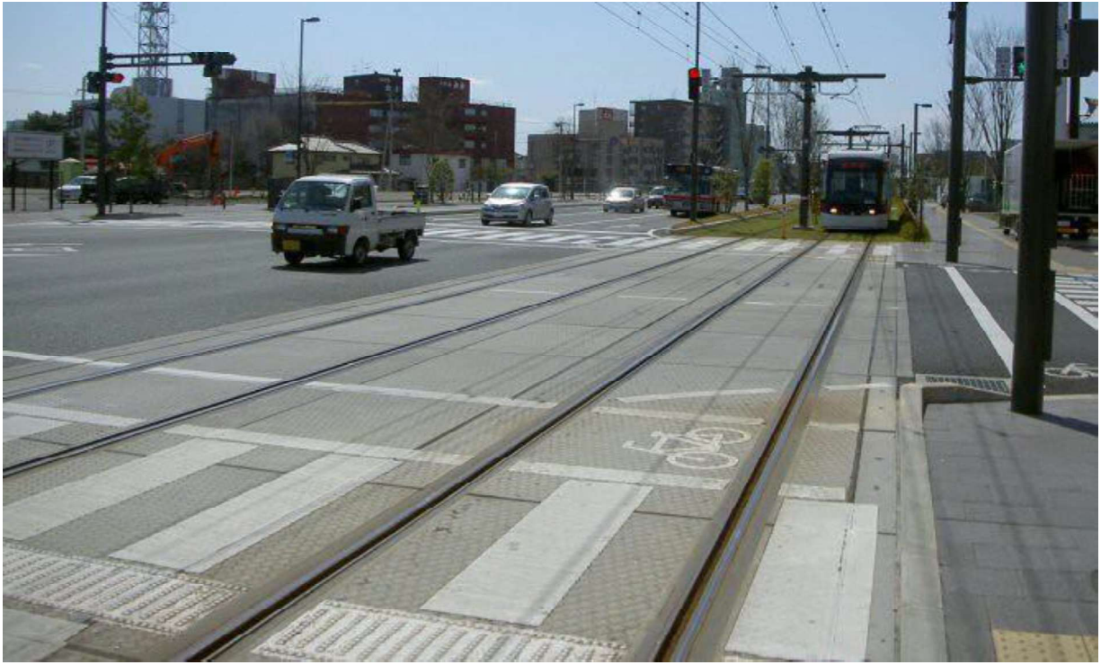
併用軌道 直線部
